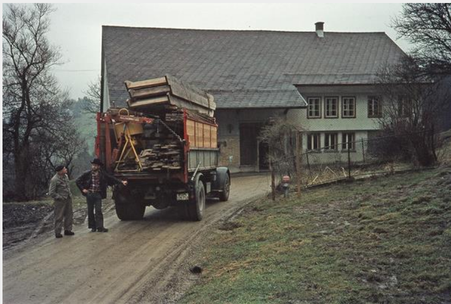
Die erste Baumaterialfuhr vor dem Haus. Links vom Lastwagen Jakob Bertschinger sen. und sein Sohn Jacobus. Photo: Billy
